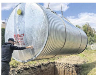
Une 5 e réserve d'eau, à savoir une cuve enterrée, a été installée à Flipou. Le chantier vient clore le dossier de la mise aux normes en termes de défense extérieure contre l'incendie. Photo transmise
